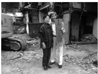
蔦茂解体時に本館建設時の棟札が見つかりました。左は「魚留」の板倉恭子さん。
