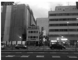
現在の御園銀座入口にある大甚中店と工事の進捗する御園座ビル
