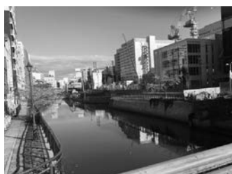
天王崎橋より北を望む
