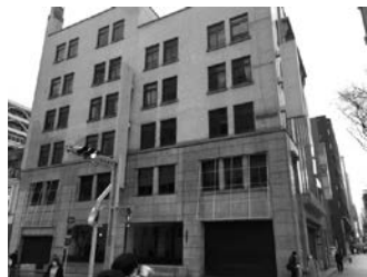
明治屋ビル全景
