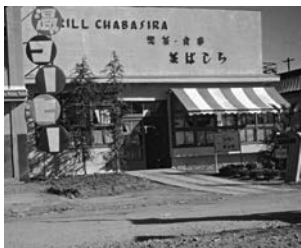
拡張工事中のステート座通りを挟んで喫茶「茶ばしら」
