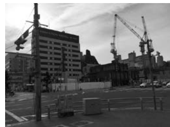
工事中の新伏見金融街。伏見三蔵交差点より御園座を望む
