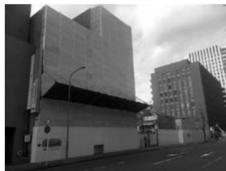
解体工事の紅葉屋（手前）、奥のビルは昔屋こと岡谷鋼機
