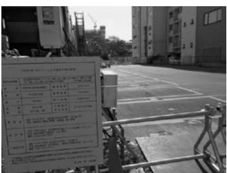
東建コーポレーションの工事現場を北から見る(旅館八幡、双葉屋跡地)
