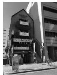
八木久ビルにはオシャレな飲食テナントやクリニックが入居。屋上に創業1872年と掲示されています
