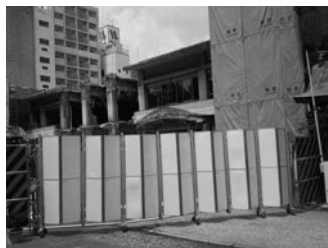
解体中の若宮会館。「若宮の杜・迎賓館」としてオープン
